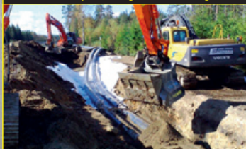
REMUS WL 160 Skyddsfillning vattenledning, Växjö-Ljungby
