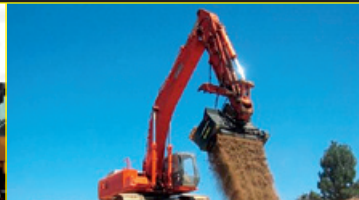
REMUS WL 250 sikt grävmaskin 40 ton, ca 200 m 3 /timme
