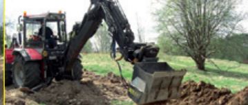
REMUS L75 Fjärrvärme LP Entreprenad, Lerum
