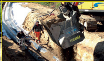
REMUS WL 160 Skyddsfillning vattenledning, Växjö-Ljungby
